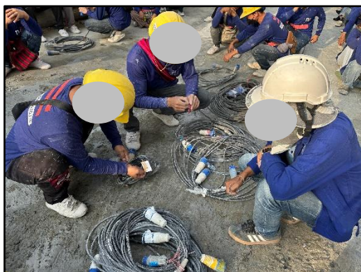
รูปที่ 47 ตรวจสอบสภาพสายไฟและอุปกรณ์ที่ใช้งาน
