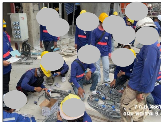
รูปที่ 47 ตรวจสอบสภาพสายไฟและอุปกรณ์ที่ใช้งาน
